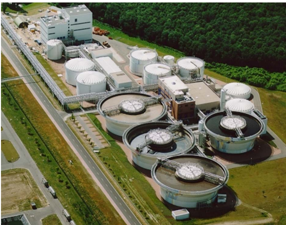
Ilustración 14: Depuradora comunitaria de Bitterfeld (altos reactores biológicos – 453.000 EW)(Proyecto piloto BMU para el tratamiento común de aguas residuales domésticas y aguas residuales de grandes empresas químicas) [5]
