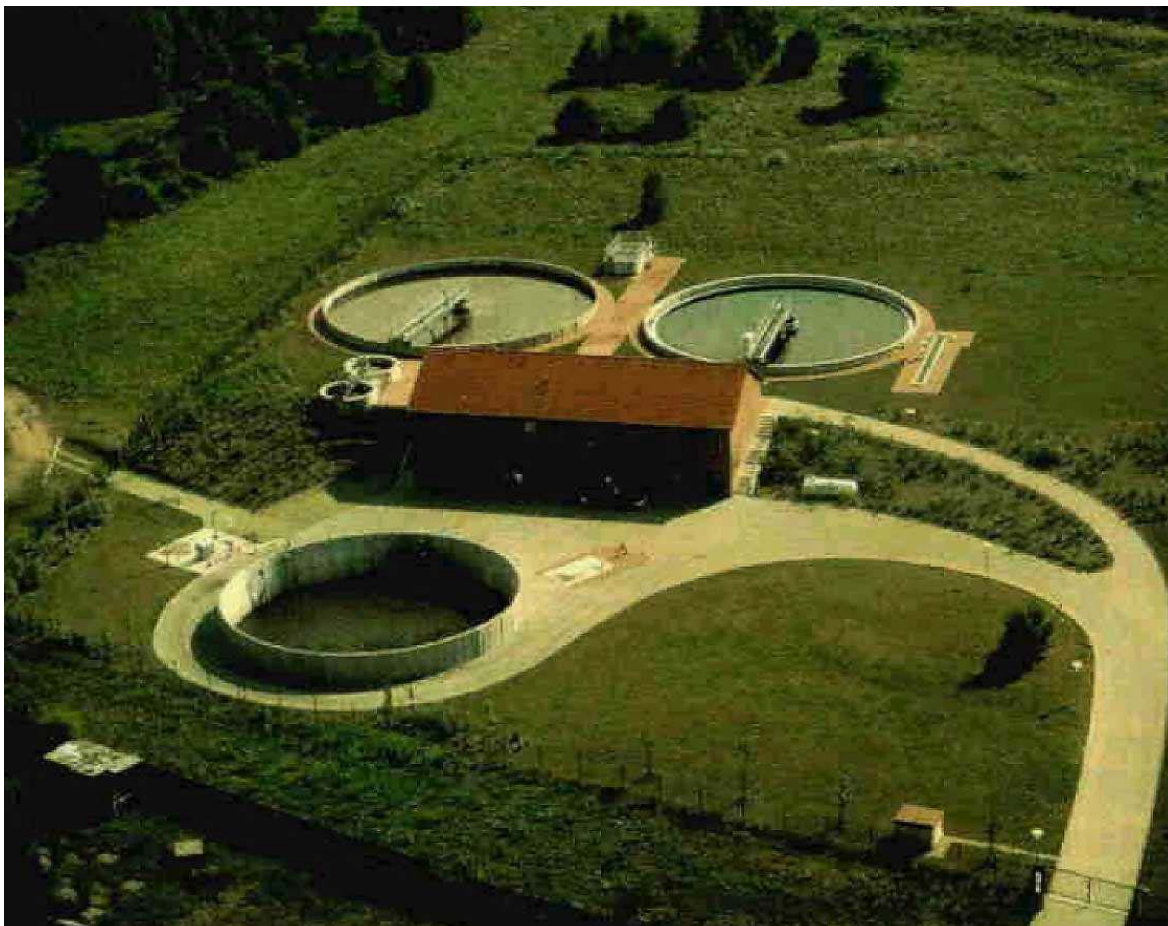
Ilustración 32: Depuradora Königsbrück – 1ª etapa de construcción
