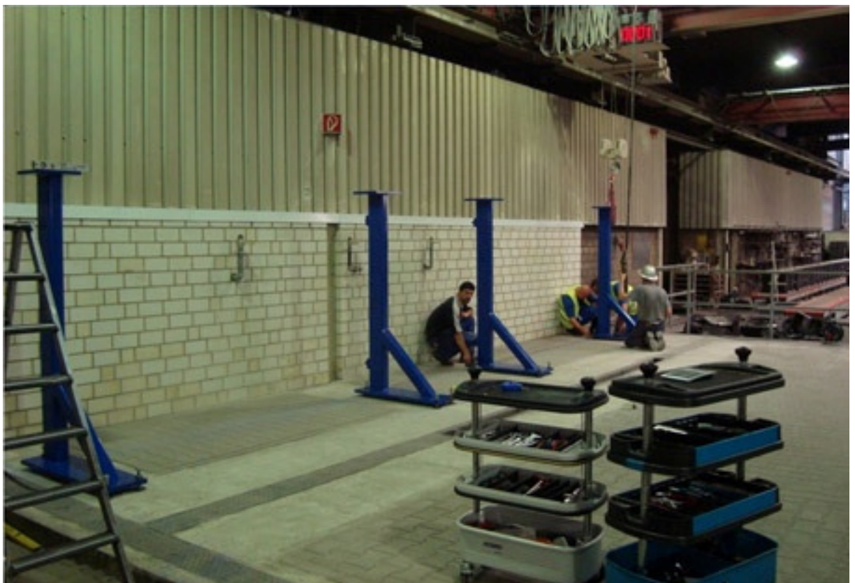
Abbildung 15: 1. Schritt aufstellen der Stützen
