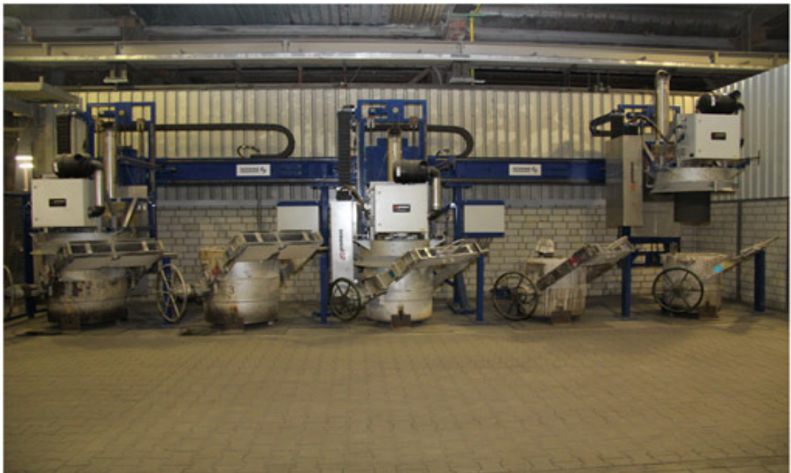
Abbildung 1: Halbautomatische Gesamtanlage zur kontrollierten Pfannenbeheizung bzw. -trocknung mit 5 Parkplätzen und drei Beheizungssysteme
