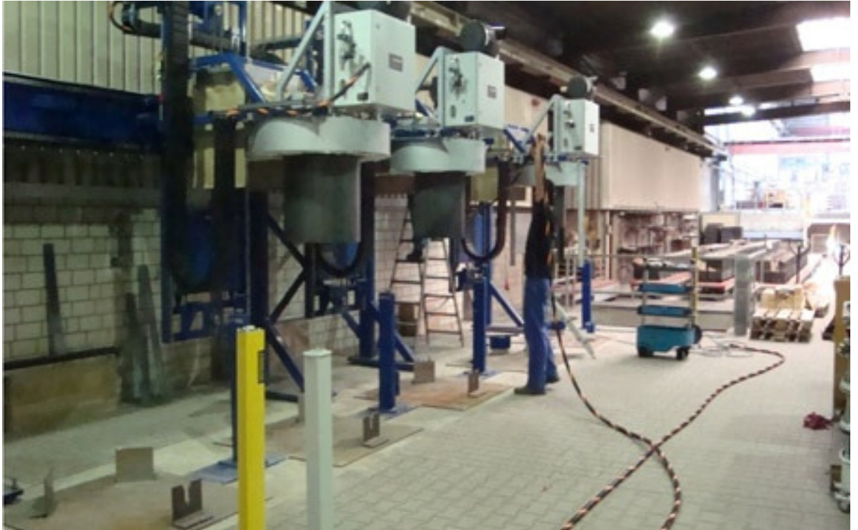
Abbildung 18: Legen der Versorgung mit Medien (Gas, Strom)
