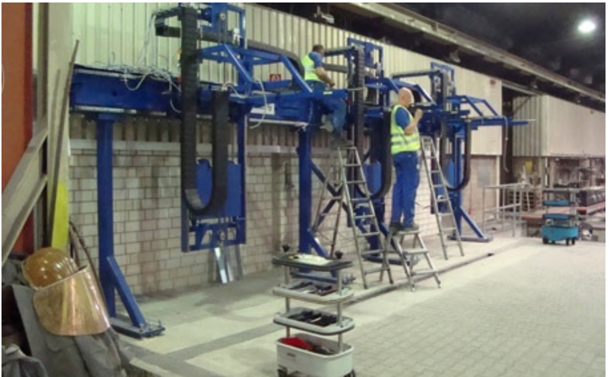
Abbildung 17: 3. Montage der Schlitten
