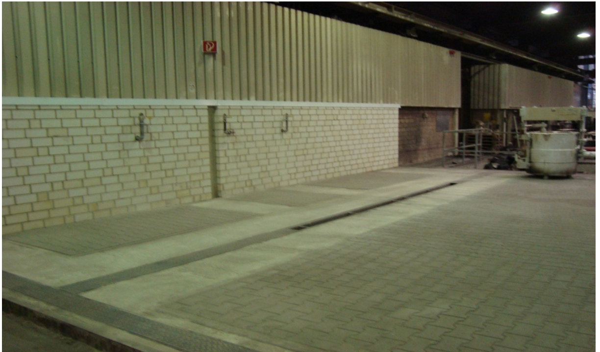
Abbildung 14: Leerer Bauplatz in der Halle von Fa. Schmees
