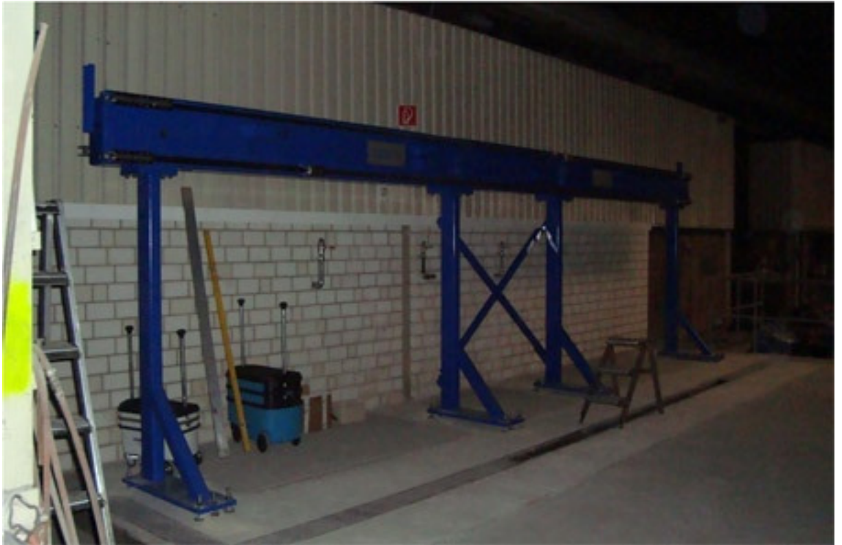
Abbildung 16: 2. Montage des Hauptträgers
