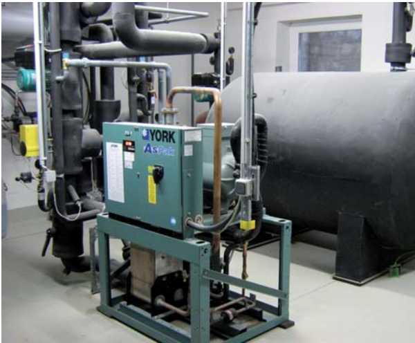
Die neue Kältemaschine in Bad Elster
