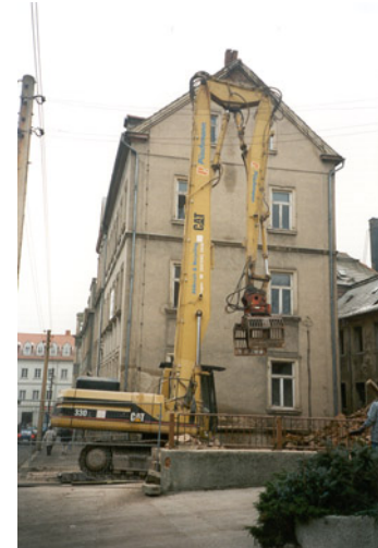
Abbildung 4-2: Einsatz von High-Lift Technik für den Gebäuderückbau
