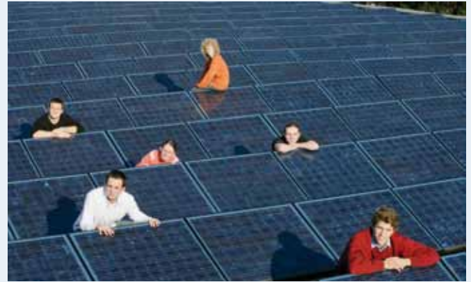
Heidelberg, E-Team und PV-Anlage auf dem Helmholtzgymnasium
