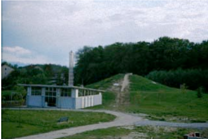
Abbildung 29: Saisonaler Speicher (12 000 m 3 ) in Friedrichshafen-Wiggenhausen
