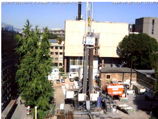
Abbildung 22: Geothermische Bohrung an der RWTH Aachen zur Wärme- und Kälteversorgung des Super-C-Centers
