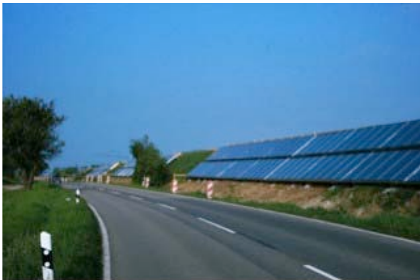
Abbildung 27: Lärmschutzwall mit Kollektor in Neckarsulm-Amorbach
