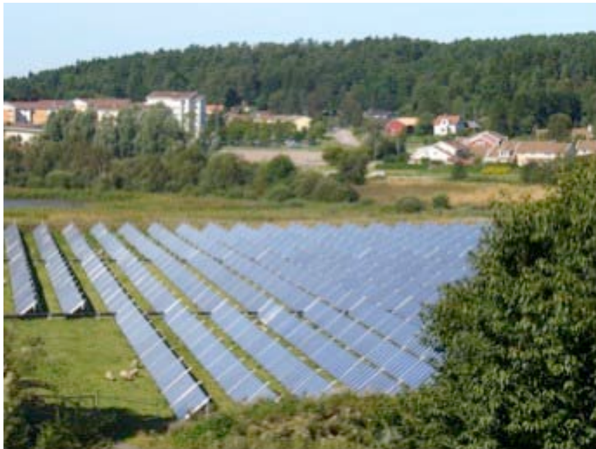
Abbildung 26: Kollektorfeld in Kungälv/Schweden
