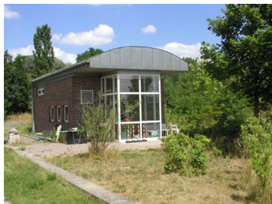
Abbildung 7: Messstation in Südansicht (Photo IV 2.6).
