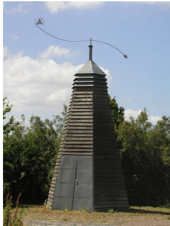
Abbildung 6: Brunnenturm in der Süd-West-Ecke der Liegenschaft in der Ostansicht (Photo IV 2.6).
