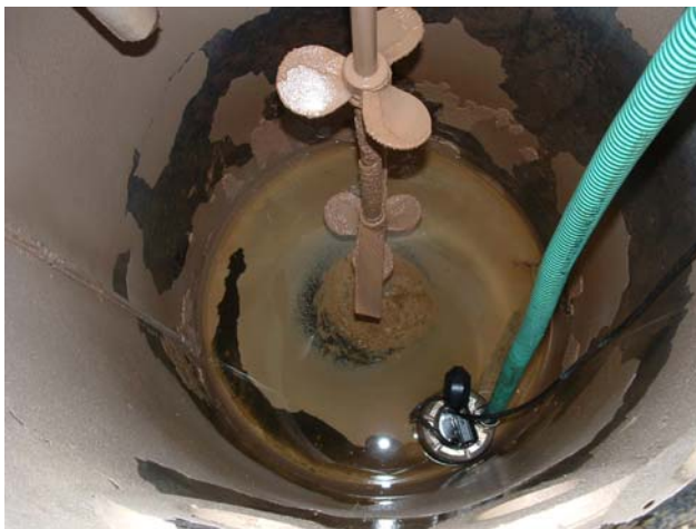
Bild 8.40: Mischreaktor mit anhaftendem braunen Kalkfällschlamm
