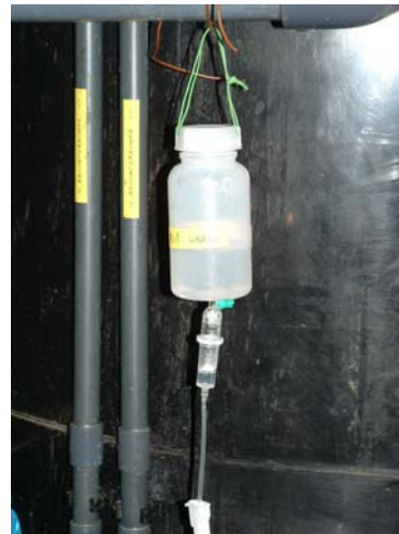
Bild 8.39: Fällmitteldosierung
