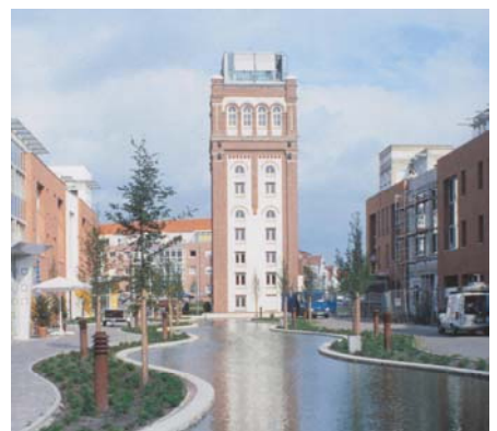
Wahrzeichen Povelturn während und nach der Umgestaltung (Fotos © Stadt Nordhorn)
