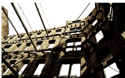
Leerstand in den Innenstädten (Foto: © Kälberer)
