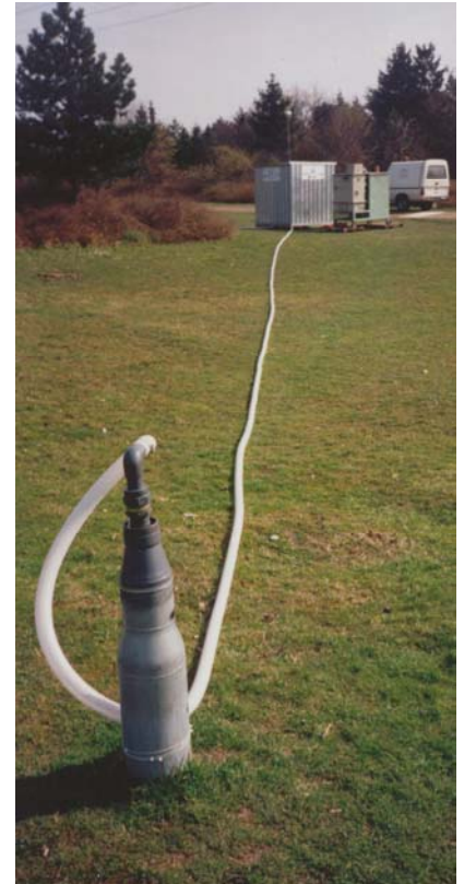
Sanierung mit angemessenem Aufwand: Bodenluftabsaugtest in einer öffentlichen Parkanlage (Foto: © Kälberer)
