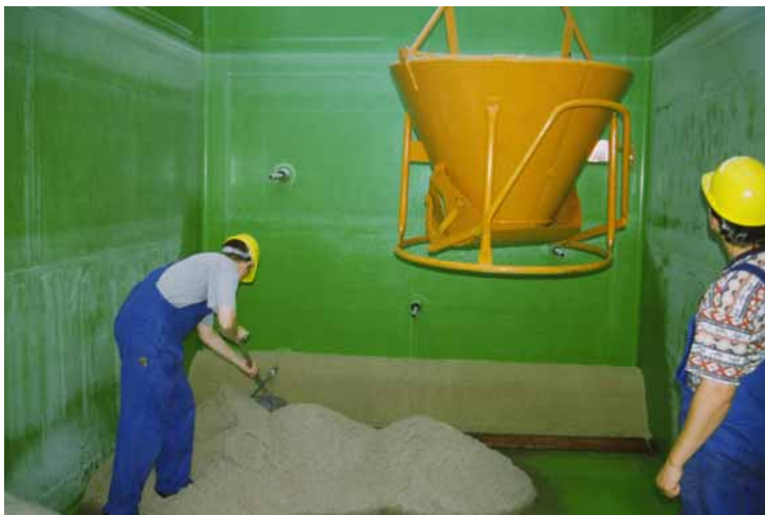
Abb. 8: Befüllung eines Versuchsteichs mit Sand. Im Hintergrund, unten: fertig eingebettete Drainage (August 2001) (Quelle: Autoren)
