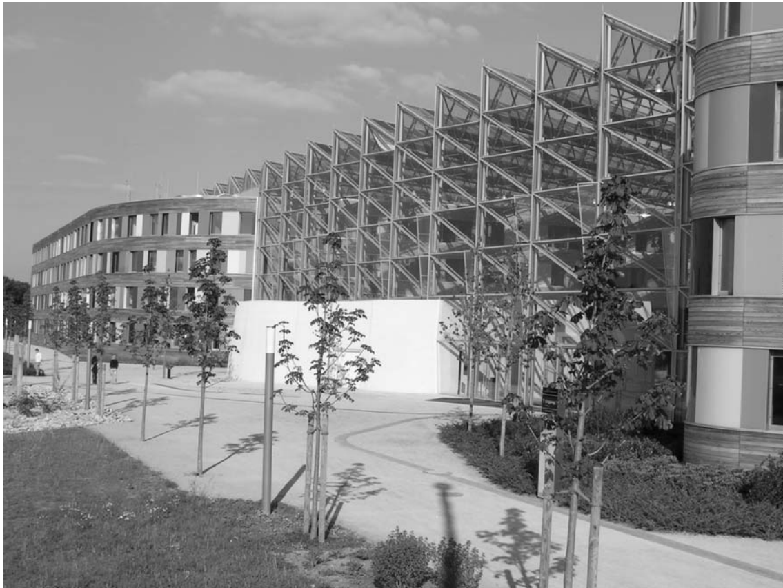
Abbildung 1: Das neue Dienstgebäude des UBA in Dessau
