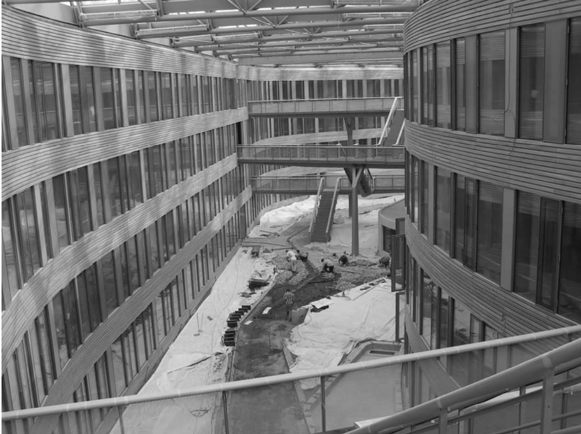
Abbildung 1: Blick in die Baustelle des Atriums des UBA-Neubaus in Dessau
