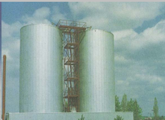
Abbildung 34: Bioreaktor zur Vergärung organischer belasteter Abwässer [15]
