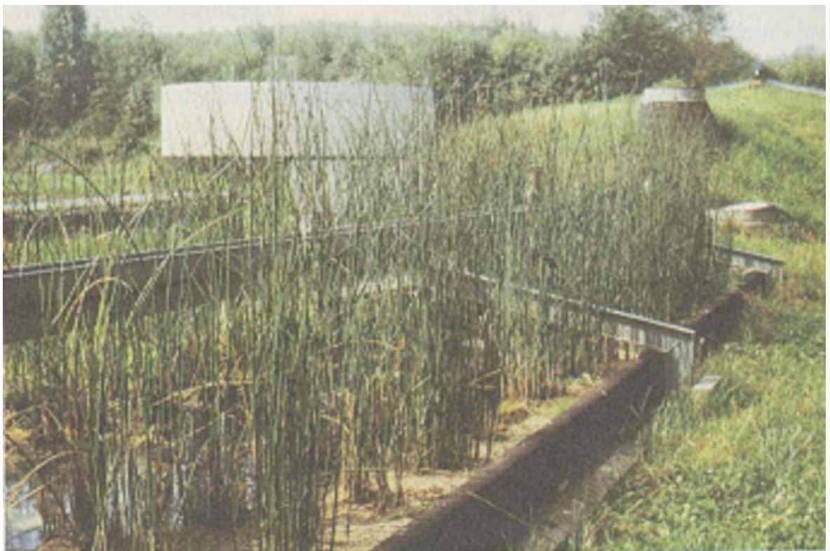
Abbildung 23: Pflanzenkläranlage [22a]
