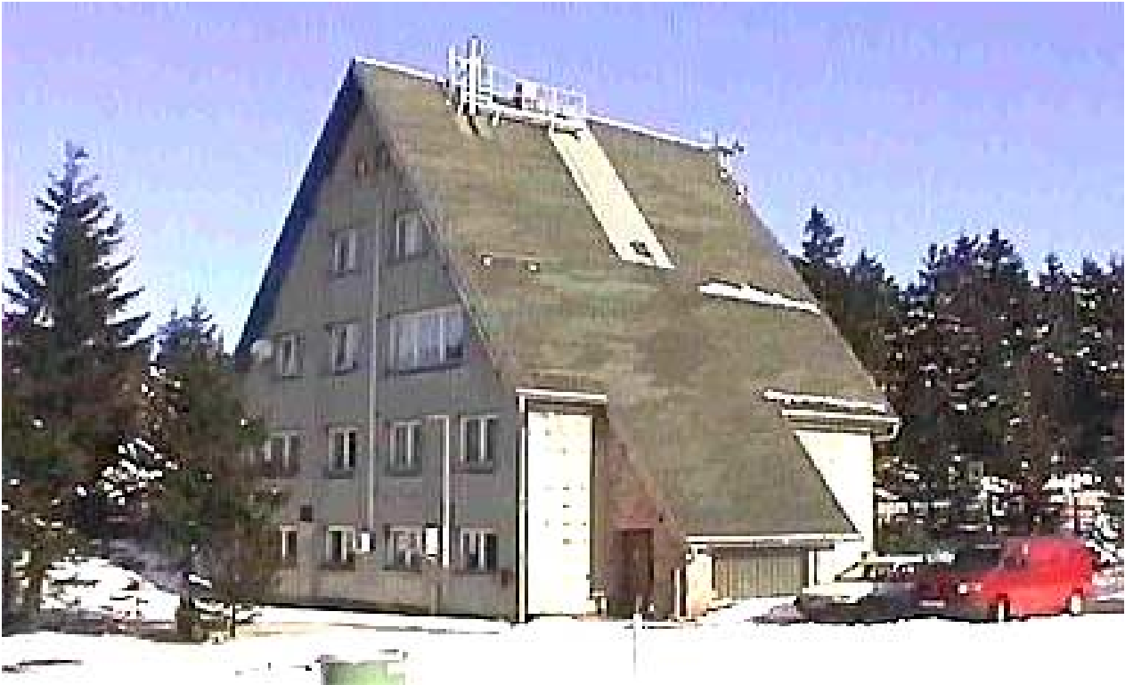
Foto 7: Messstelle Schmücke auf dem Kamm des Thüringer Waldes.
