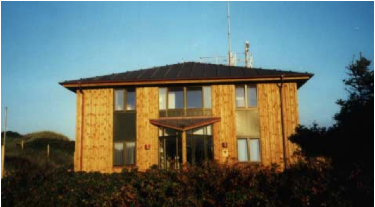
Foto 3: Messstelle Westerland auf Sylt. Der nördlichste Punkt des Messnetzes, direkt an der Nordsee gelegen.
