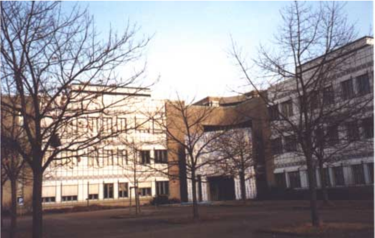
Foto 11: Außenstelle Langen mit Messnetzbetriebszentrale
