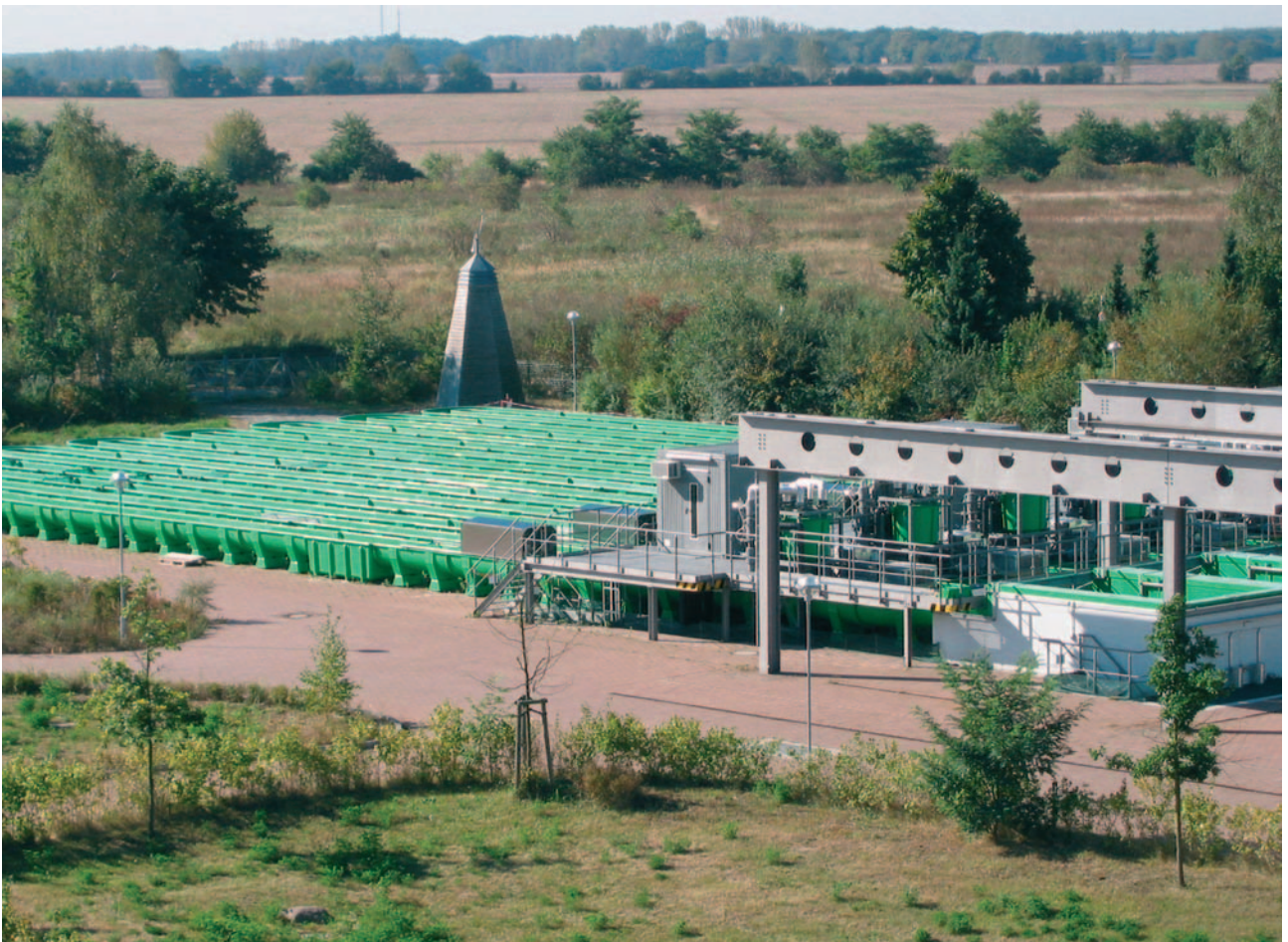
Ein riesiges Labor unter freiem Himmel: Außensicht auf die Fließgewässer-Simulationsanlage. In Rinnen und Teichen werden die Auswirkungen von Chemikalien auf die Umwelt simuliert. (Foto: UBA/Feibicke)
