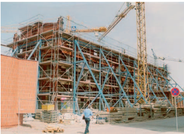
Ein Baugerüst stützt die künftige Bibliothek des UBA. (Foto: UBA/Olesch)
