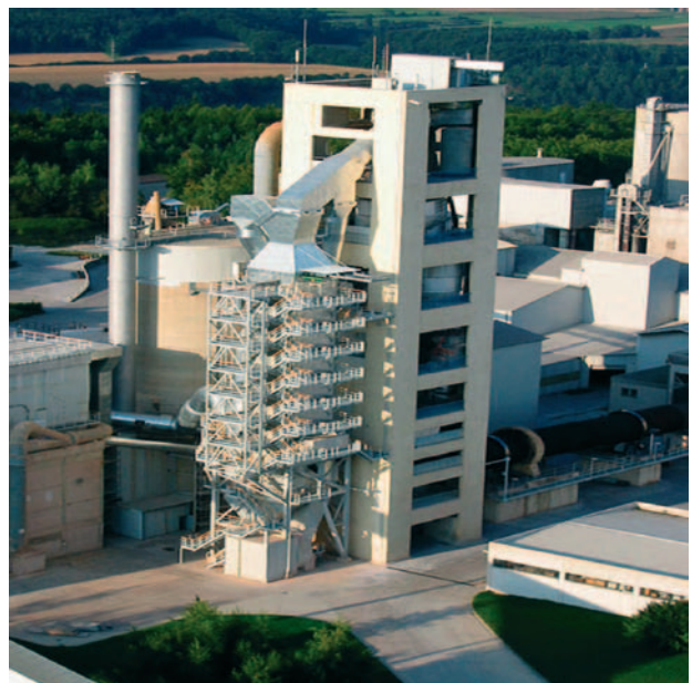
Solnhofer Portland Zementwerke AG: Weltweit die erste Betriebsanlage mit SCR-Technik. (Werkfoto)
