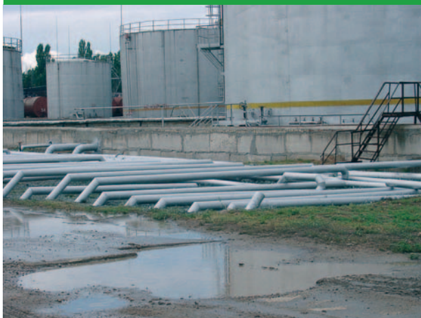
Abbildung 8: Sanierungsbedürftige Rohrleitungen eines Tanklagers in der Ukraine (Beratungshilfeprojekt: Anlagensicherheit in Rumänien, Moldawien und in der Ukraine)
