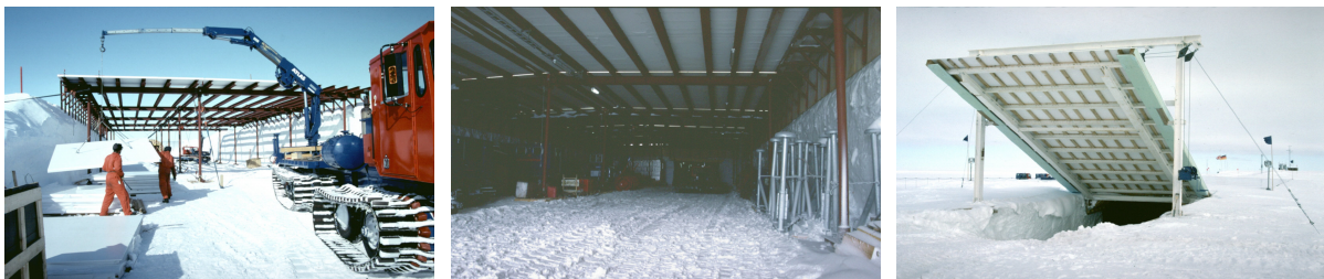
Abb. 7-4 Neumayer Garagengebäude: Bau, Innenansicht, Rampendeckel
