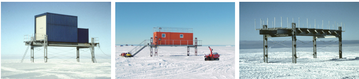
Abb. 7-11 Aufgeständerte Plattformen: Ballonfüllhalle, Seismik/Infraschall Observatorium, und ohne Aufbauten
