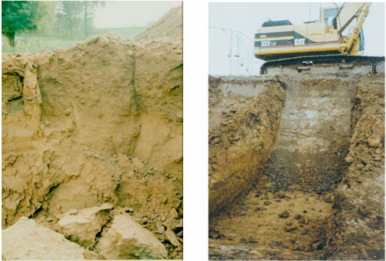
Abbildung 9.6.3.2.1: Risse als Folge größerer bergbaulich bedingter Zerrungen (links) und ihre Beseitigung durch Aufgrabung und Wiederbefüllung (rechts).
