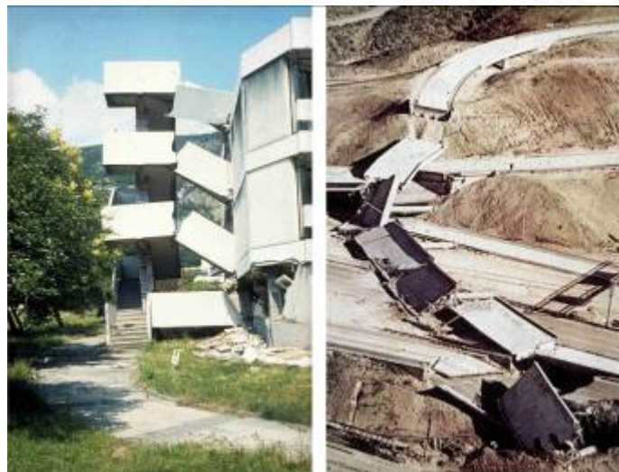
Abbildung 8.3.2.1: Seismische Bauwerksschäden: Vollständige Zerstörung des Erdgeschosses (links) und des kompletten Brückenüberbaus (rechts)
