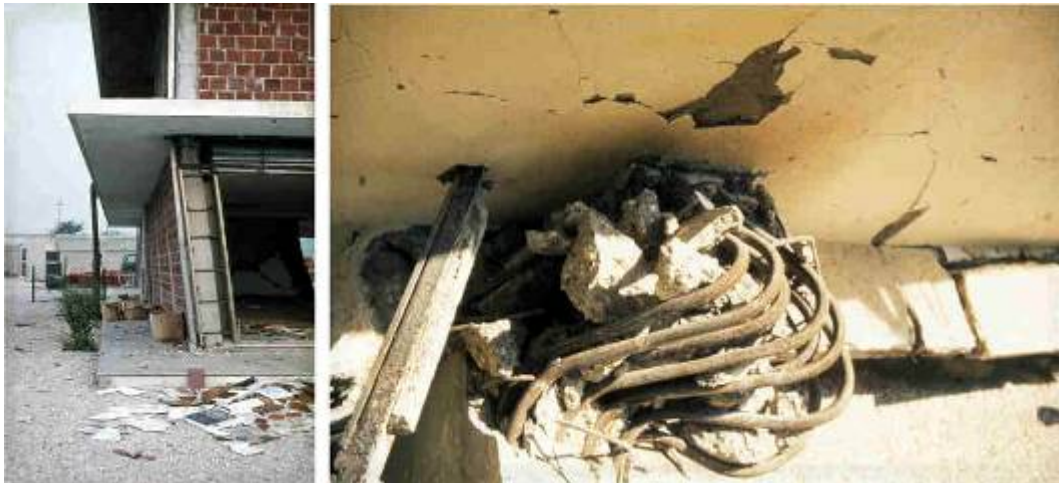
Abbildung 8.1.3.1: Seismische Tragwerksdeformationen
