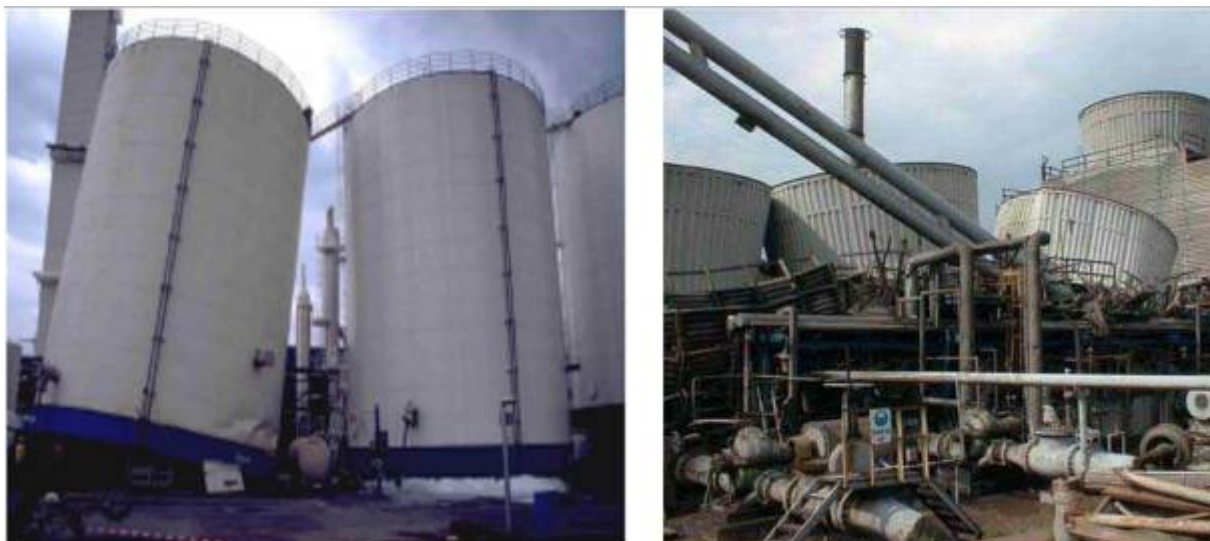
Abbildung 8.7.3.5.3: Schäden in Industrieanlagen beim Bingöl-Erdbeben 2003
