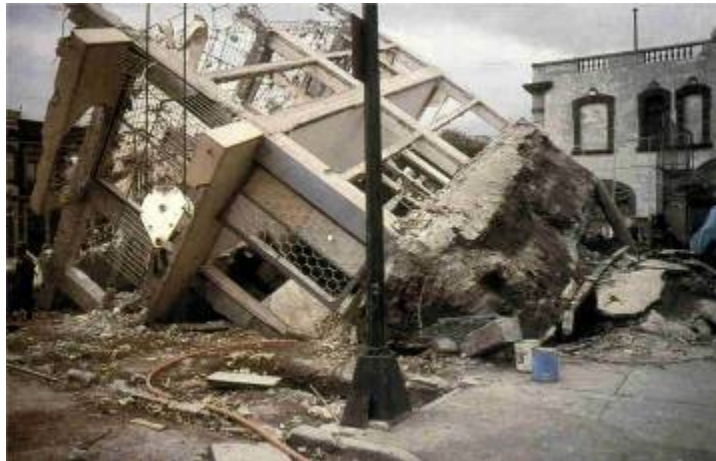
Abbildung 8.3.2.2: Seismischer Bauwerksverlust durch Bodenverflüssigung
