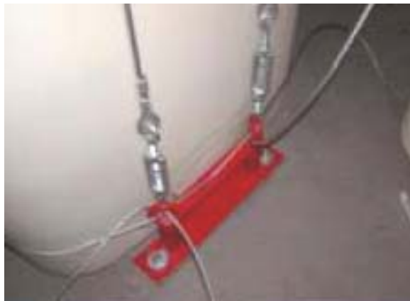
Abbildung 7.2.2.1: Sicherung eines Tanks vor Auftrieb durch Stahlgurte
