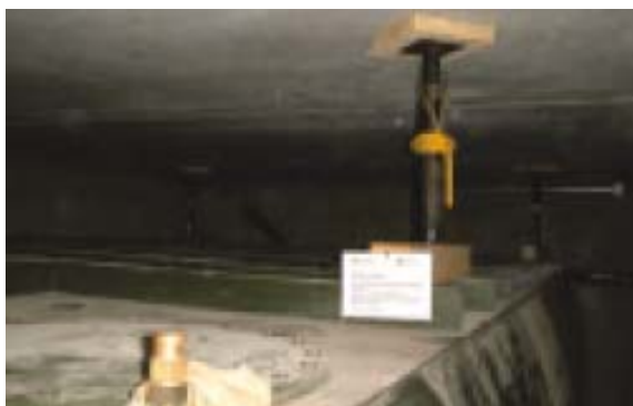
Abbildung 7.2.3.1: Stempel zur Sicherung eines Tanks gegen Auftrieb
