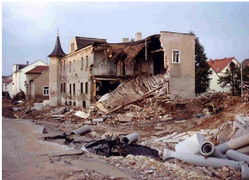
Abbildung 5.7.1: Hochwasserschäden in Dohna an der Müglitz (August 2002)
