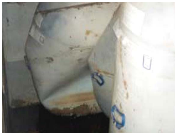
Abbildung 4.1.1: Eingebeulter Heizöl-Lagerbehälter
