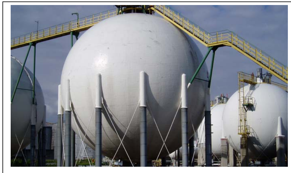
Abbildung 4.4.3.1: Kugellagertanks für Flüssiggas
