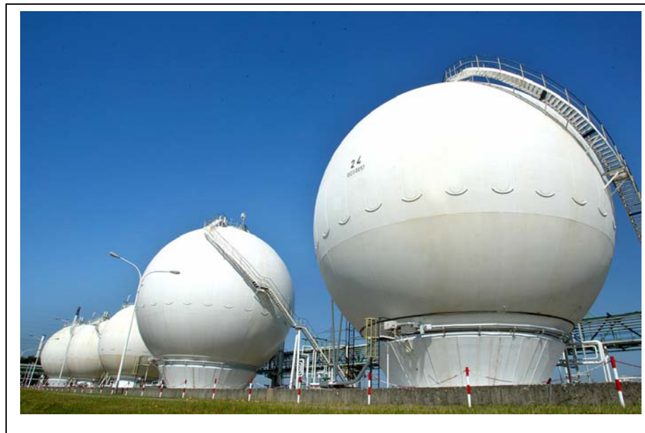
Abbildung 4.4.3.2: Sanierte Kugellagertanks für Flüssiggas
