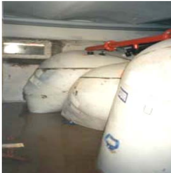
Abbildung 4.1.2: Aufgeschwommene Heizöl-Lagerbehälter
