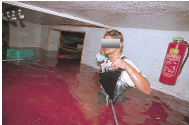
Abbildung 4.1.3: Ausgetretenes Heizöl in einem Keller
