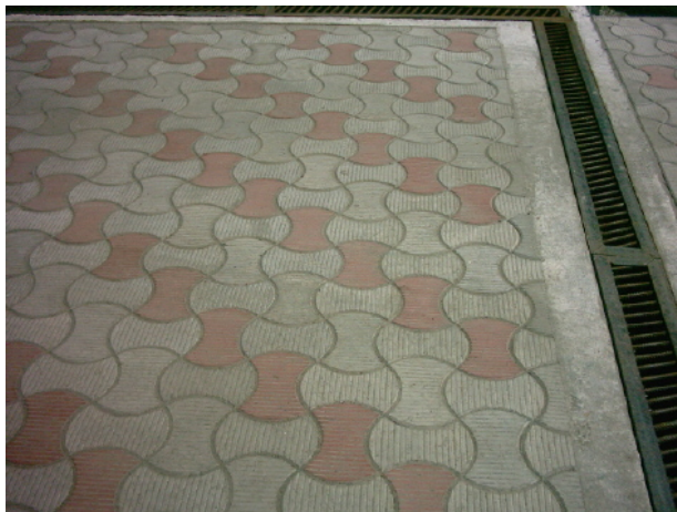
Abbildung 6: Abfüllfläche der Betriebstankstelle
