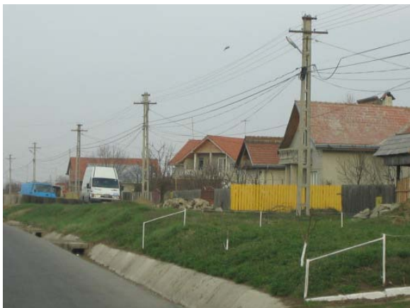
Alimentarea cu energie într-o localitate rurală din România. Foto: IDCED e.V.
