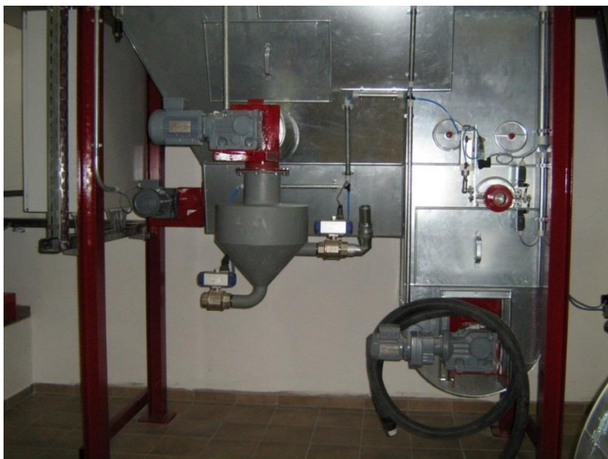
Abbildung 11: Abgasreinigung nach dem Kugelrotorumlaufverfahren im Tierkrematorium Badbergen
