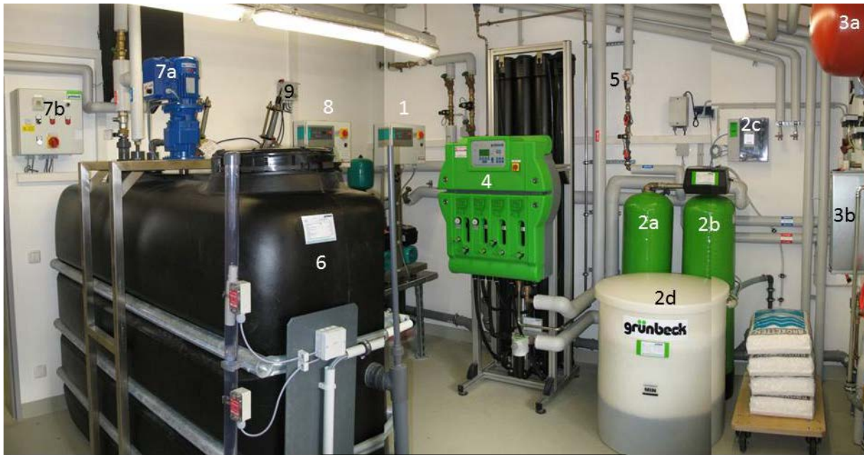
Abbildung 3: Wasserführung in der ökotoxikologischen Expositionsanlage
