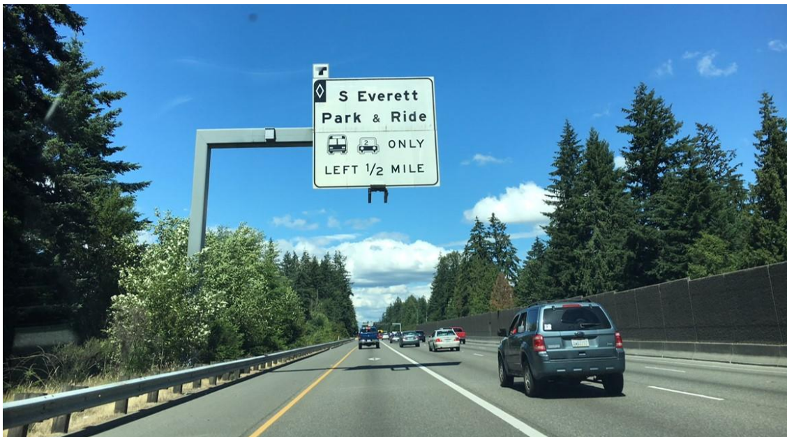
Abbildung 7: Ankündigung einer Rampe zum P+R für Busse und Fahrzeuge der HOV-Spur
