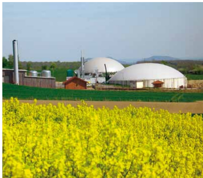
Bioergieanlage im Bioenergiedorf Jühnde
