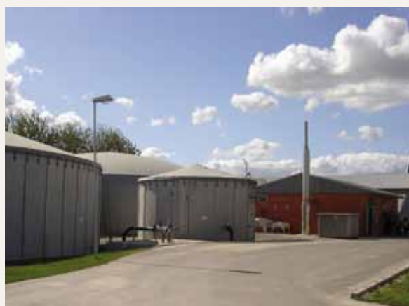
Planta de biogás en Feldheim
