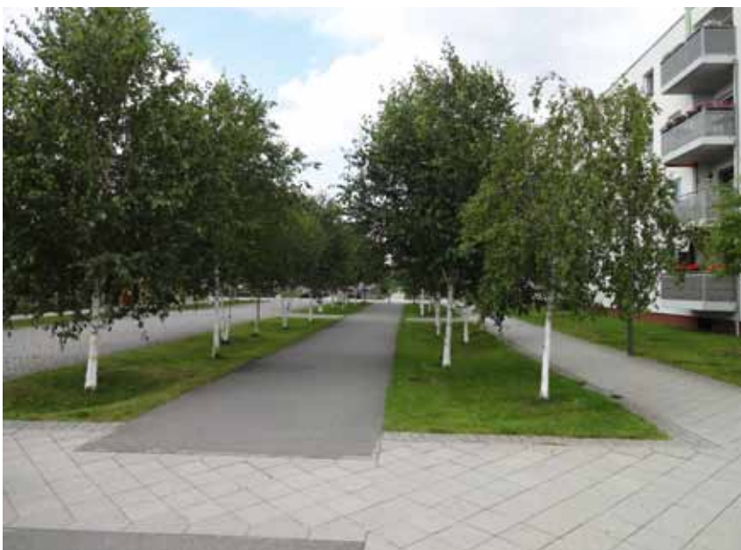
Versickerungsmulden im Hochschulstadtteil Lübeck
