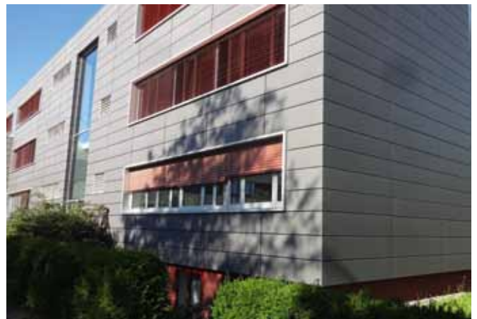
Flexible Verschattungselemente lassen sich dem Sonnenstand anpassen: Konrad-Wachsmann-Allee in Cottbus
