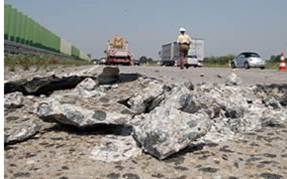
Abbildung 4: Beschädigte Betonplatten auf der A29 im Sommer 2010 3
