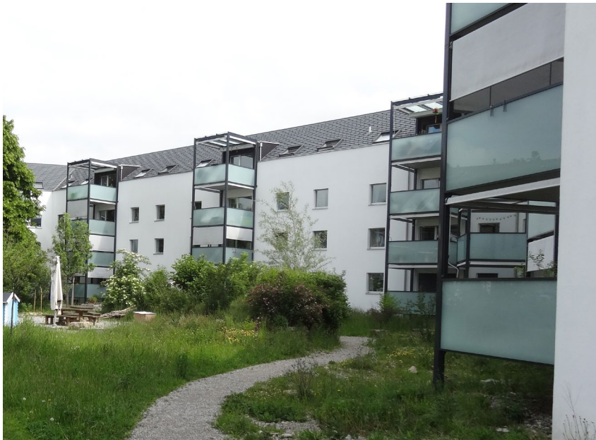
Schaffung von naturnahen Lebens- und Erholungsräumen bei der Sanierung der Siedlung Fröschmatt in Bern (Foto: Alice Schröder)
