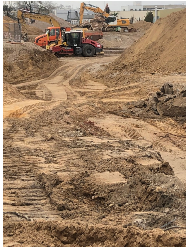
Aushub auf einer Baustelle (Foto Thomas Preuss)
