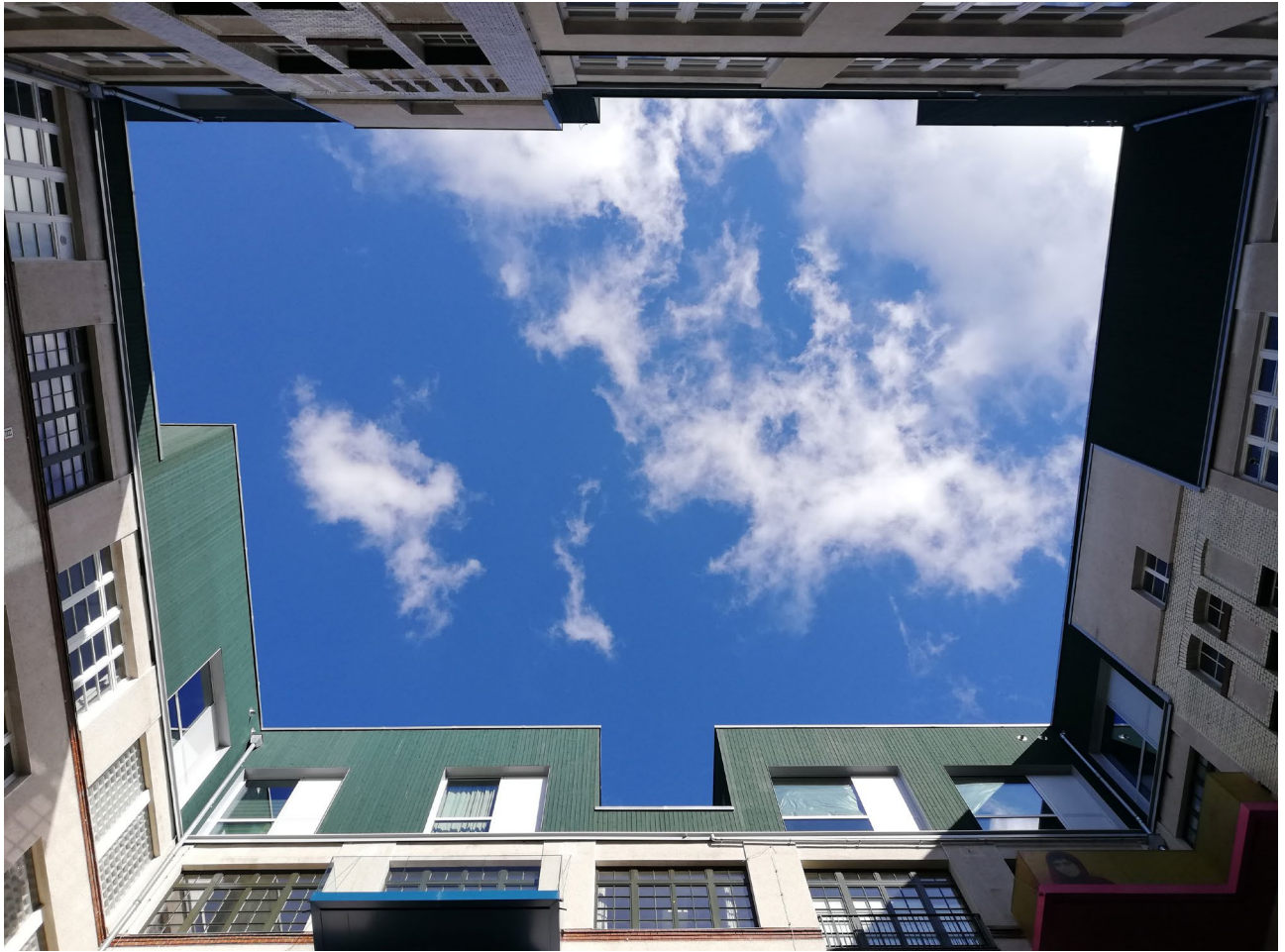
Nachverdichtung durch Dachaufbauten (Foto Maic Verbücheln)
