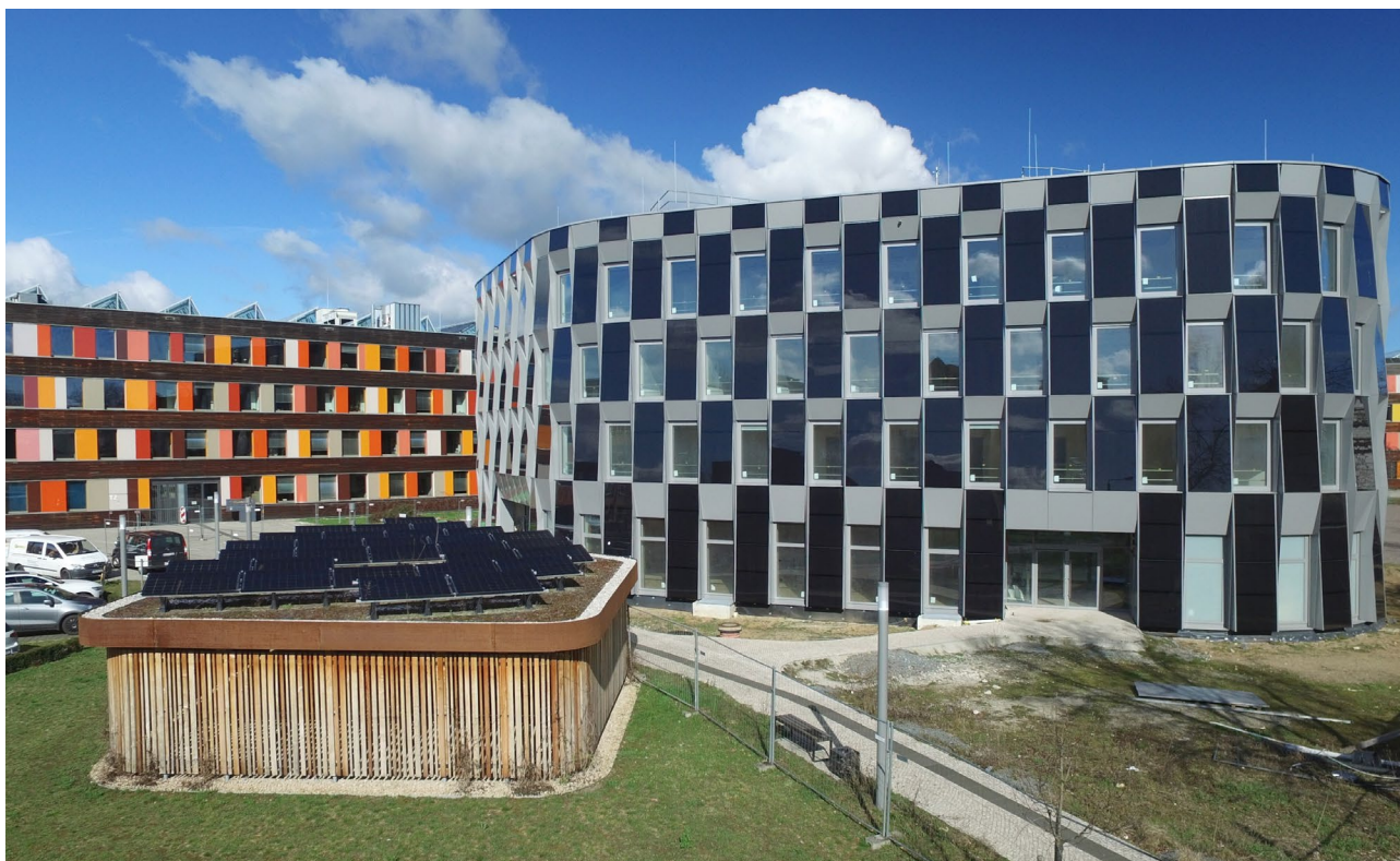
Im September 2023 hat das UBA sein zweites Bürogebäude an seinem Hauptsitz in Dessau-Roßlau eingeweiht. Das Plus-Energie-Gebäude ist darauf ausgelegt, nicht nur den eigenen Energiebedarf vollständig zu decken, sondern möglichst auch zusätzliche Energie zu erzeugen.
