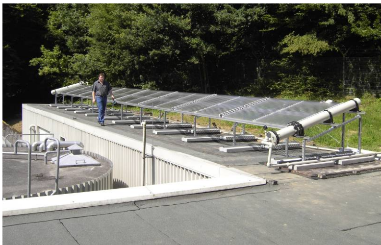
Abbildung 6: Solare Wasserreinigungsanlage (32 m 2 ), DLR Lampoldshausen
