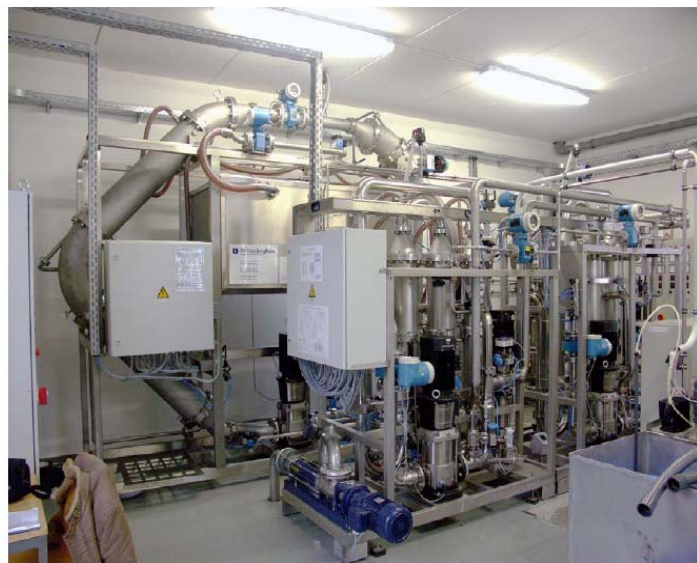
Abbildung 3: Erweiterung der Membrananlage zur Reinigung von Textilabwasser bei der Riedel Textil GmbH; Anlagenbauer: Junghans, Frankenberg /13/
