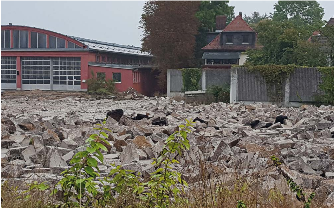
Abbruch einer Verkehrsfläche aus Beton
