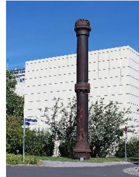
Hochdruck-Reaktor (Stahl) zur Ammoniak-Synthese nach dem Haber-Bosch-Verfahren. Erbaut 1921 von der Badischen Anilin- und Sodafabrik AG Ludwigshafen am Rhein. Aufgestellt auf dem Gelände der Universität Karlsruhe. © Drahrub https://commons.wikimedia.org/wiki/File:Ammoniak_Reaktor_BASF.jpg
