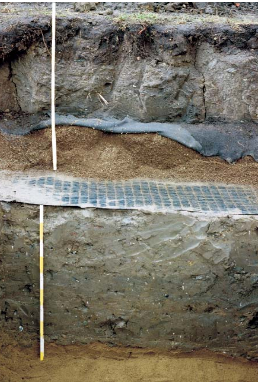
Bild 51: Aufbau des Abdecksystems für eine Altdeponie
