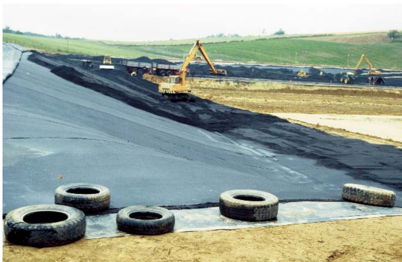
Bild 52: Bau der Basisdichtung einer Abfalldeponie
