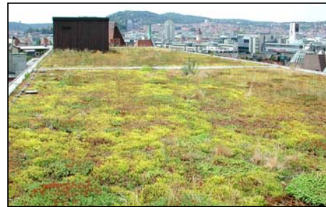
Quelle: LHS Stuttgart
