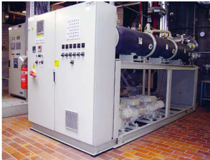
Abbildung B.3: Kompressionswärmepumpe in der Kläranlage Waiblingen
