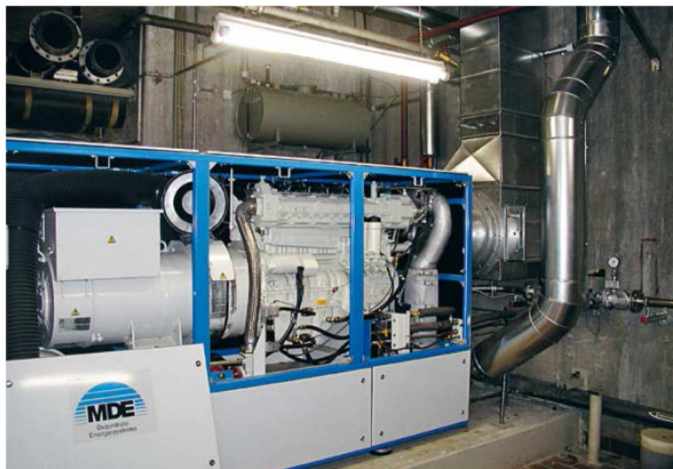
Abbildung B.2: Klärgas-Blockheizkraftwerk in der Kläranlage Waiblingen
