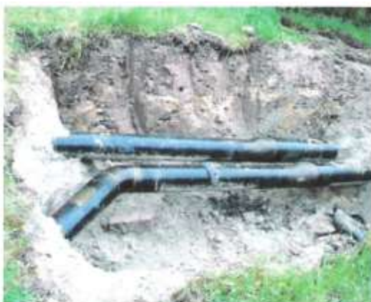
Rohrleitungen freigelegt zu Wand- dickenmessung
