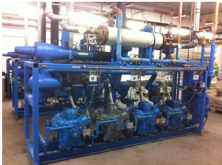
Abbildung 6: Supermarkt-Zentralanlage (Öko-Recherche 2014).
