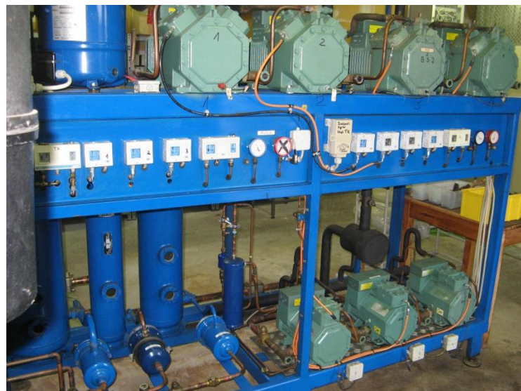
Abbildung 8: Zwei industriell genutzte Zentralanlagen (Öko-Recherche 2014).
