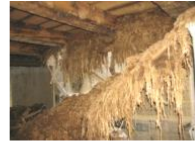
Zerstörung wasserempfindlicher Deckenbekleidungen
