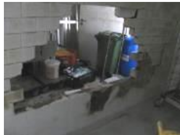
Zerstörung massiver Bauteile aufgrund hydrostatischen Drucks
