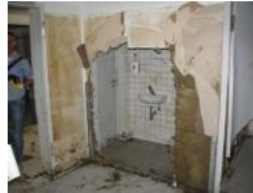
Zerstörung leichter Trennwände aus Gipskarton
