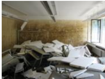
Aufschwimmen von Fußbodenkonstruktionen
