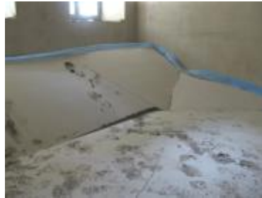
Zerstörung wasserempfindlicher Bauteile
