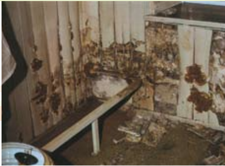
Bild 1: Echter Hausschwamm in Holzverkleidung
