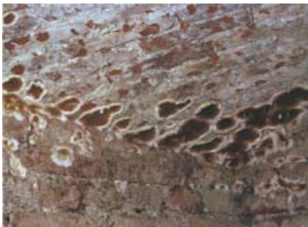
Bild 2: Echter Hausschwamm in Mauerwerk
