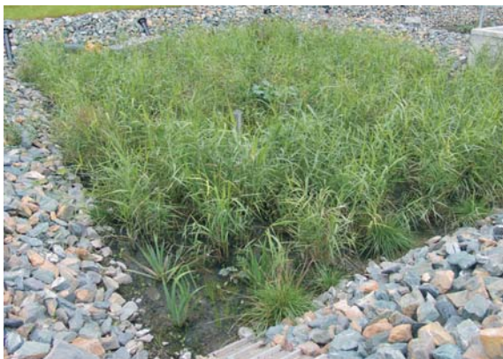
Очистные сооружения растительного типа во Фризене: растительный донный фильтр в смешанной системе с предварительным фильтром для сточной воды и
