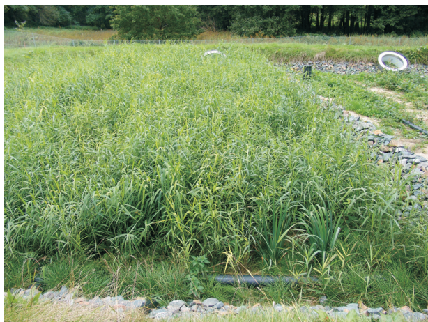
Очистные сооружения растительного типа в Германии: вертикально направленный растительный донный фильтр
