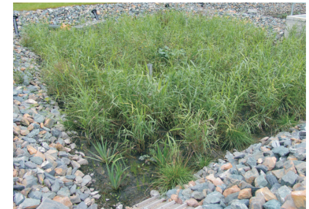
KA Friesen: Bepflanzter Bodenfilter im Mischsystem mit Rohabwasserfilter und integrierter Schlammbehandlung
