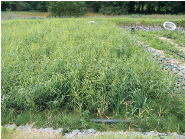
PKA in Deutschland: Vertikal durchströmter Bepflanzter Bodenfilter
