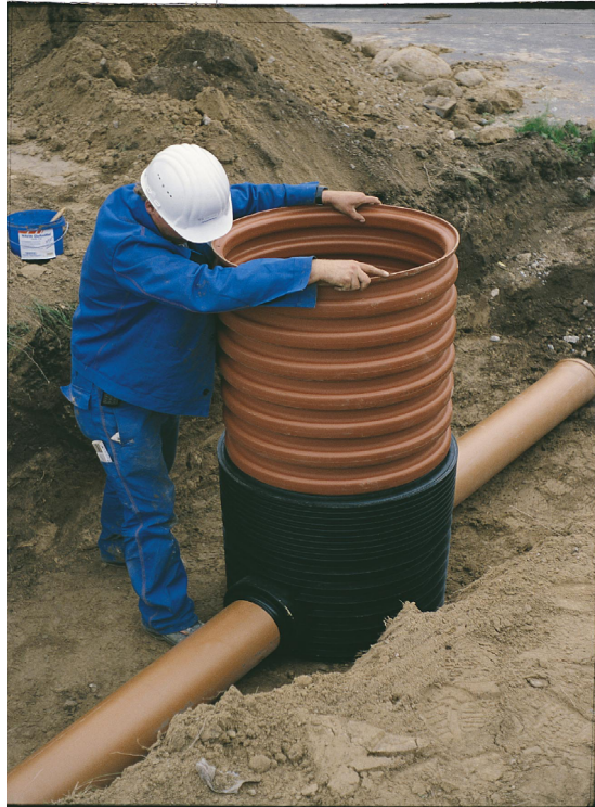
Anhang 5, Abb. 1: Inspektionsschacht Freispiegelleitung (System Wavin)
