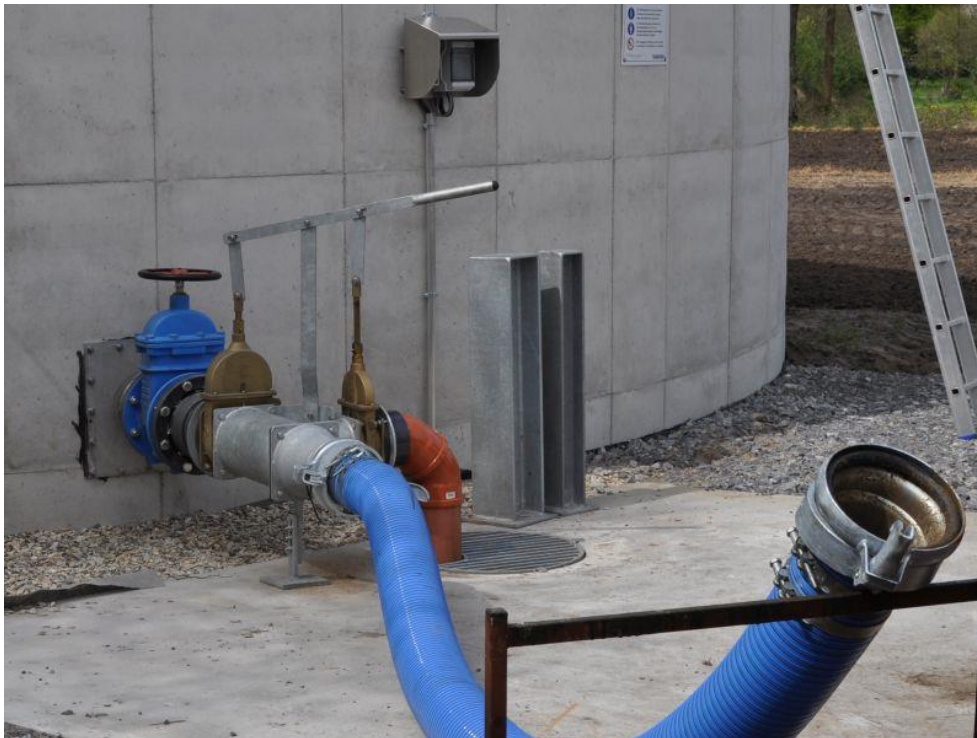
Abb. 8: Gülleabtankplatz mit Vorgrube
