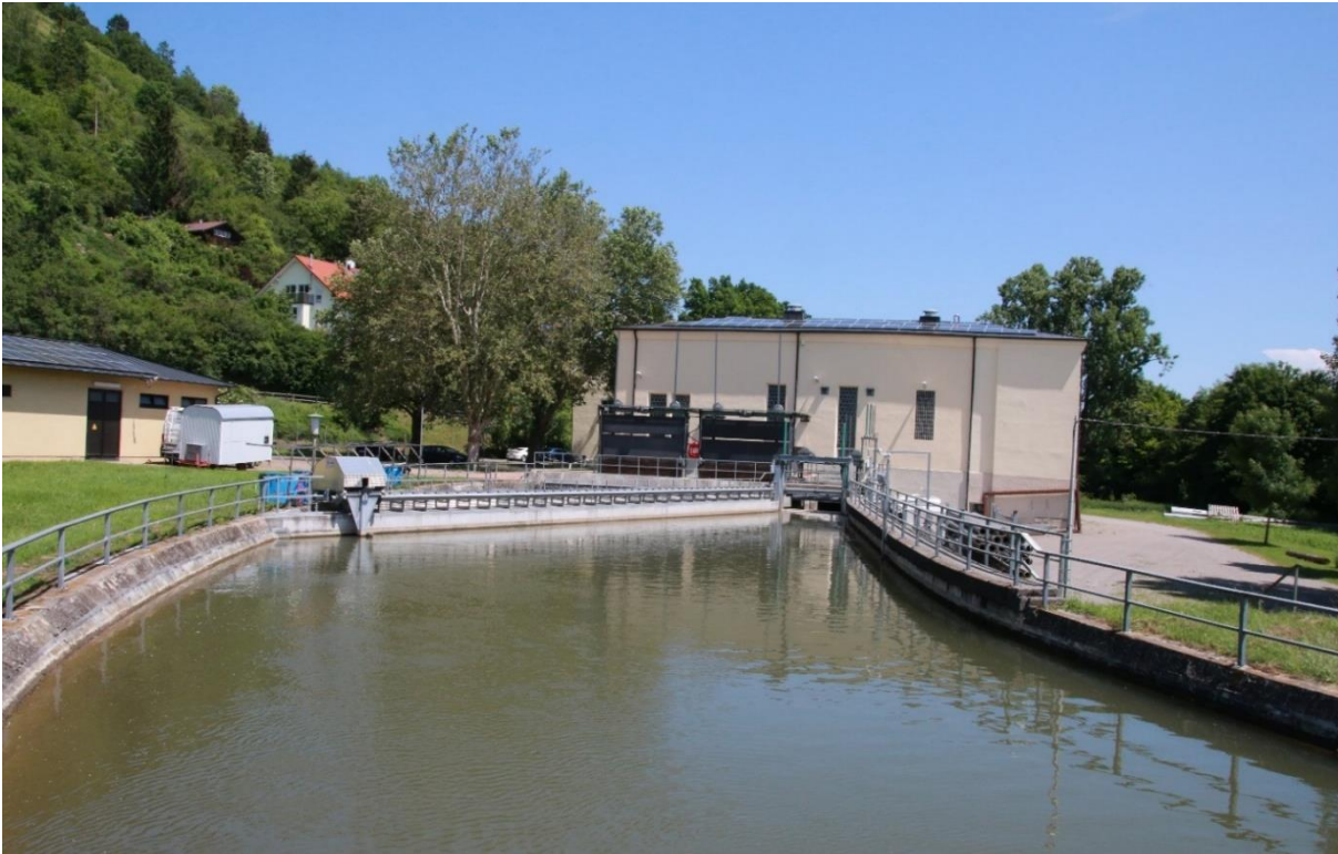
Abbildung 4: Krafthaus der WKA Rappenberghalde mit horizontalem Leitrechen aus dem Oberwasser fotografiert
