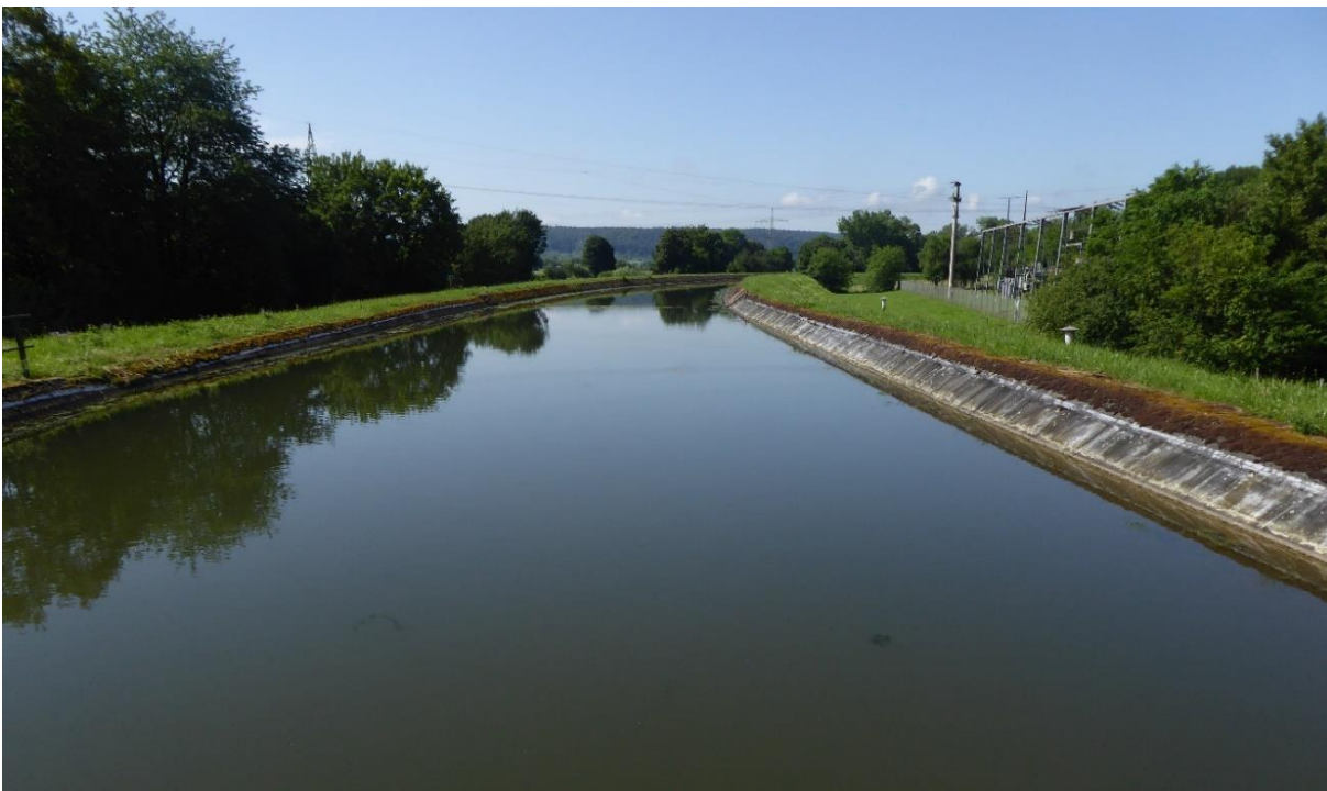
Abbildung 9: Kanal mit Trapezprofil oberhalb der Wasserkraftanlage Rappenberghalde
