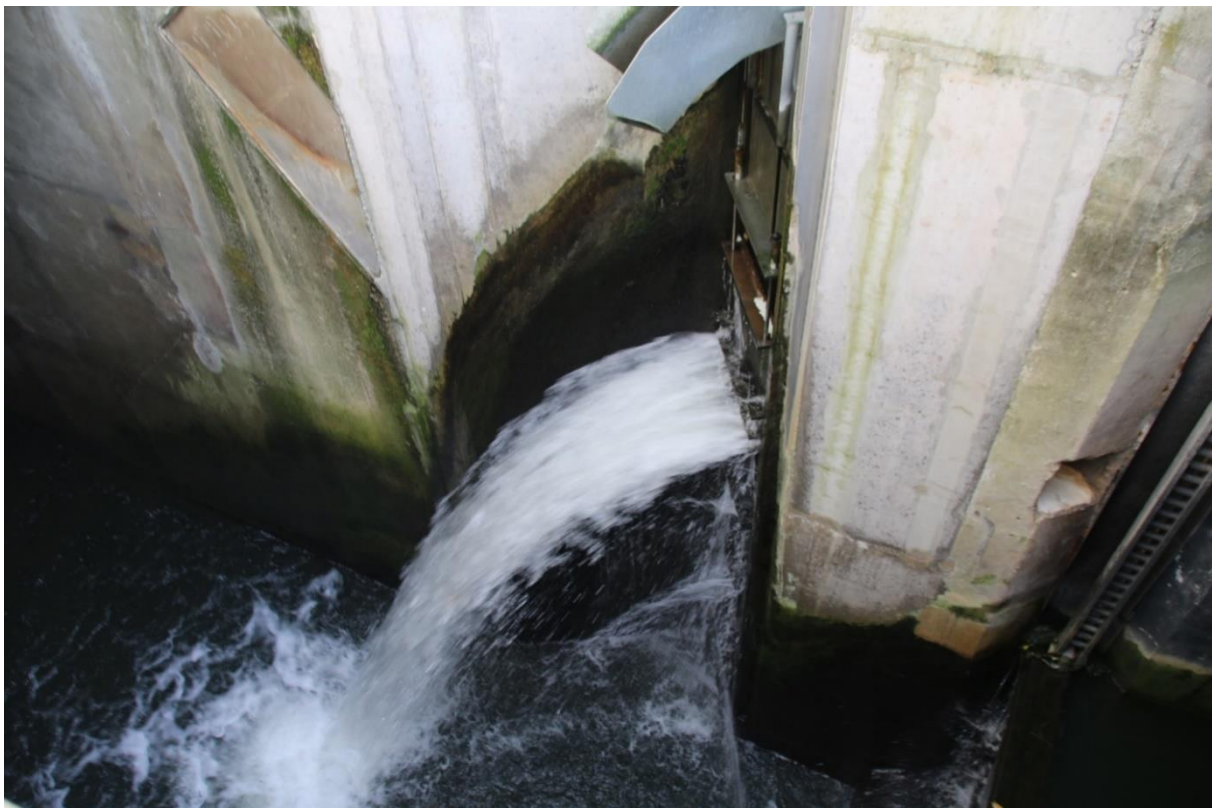
Abbildung 58: Entleerungsphase des Bypasses. Das Registerschütz ist teilweise angehoben und das Wasser aus dem Evakuierungsbecken drückt durch die Spalte, eine potenzielle Schädigungsquelle für absteigende Fische
