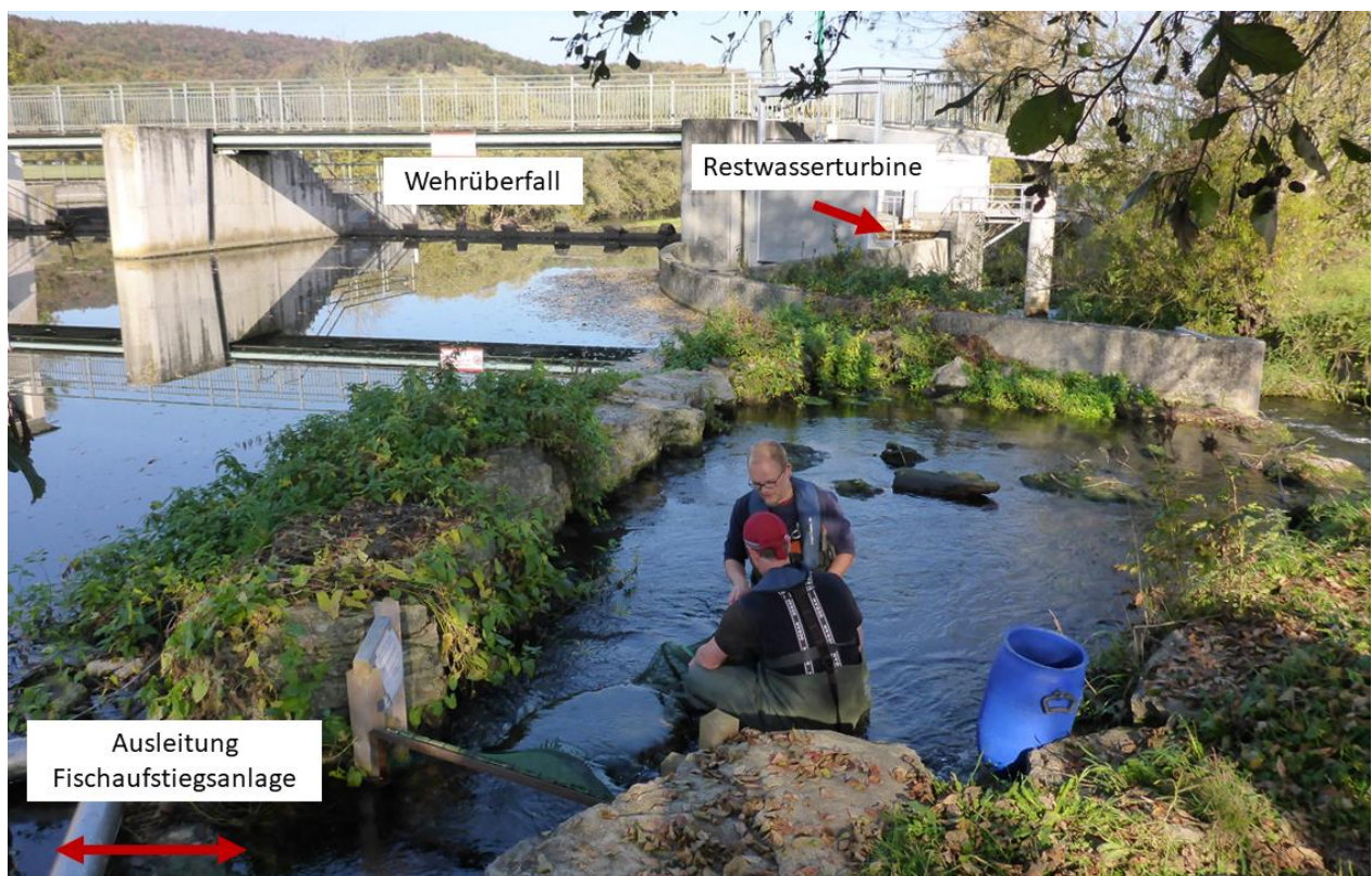
Abbildung 65: Räumliche Trennung von Fischaufstiegsanlage und Restwasserturbine
