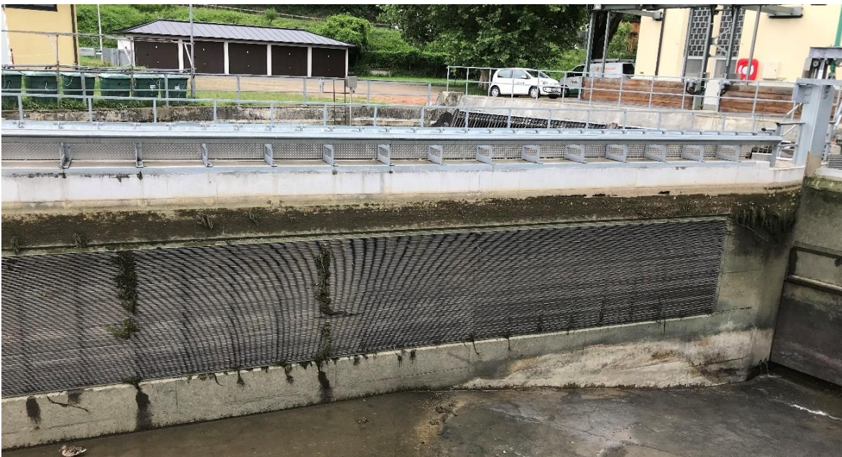
Abbildung 11: Teil des Fischschutzsystems an der Wasserkraftanlage Rappenberghalde am Neckar bei Tübingen. Blick auf den horizontalen Leitrechen mit 15 mm lichtem Stababstand und Betonsockel. Am rechten Bildrand ist das Schütz zum Leerschuss teilweise zu sehen
