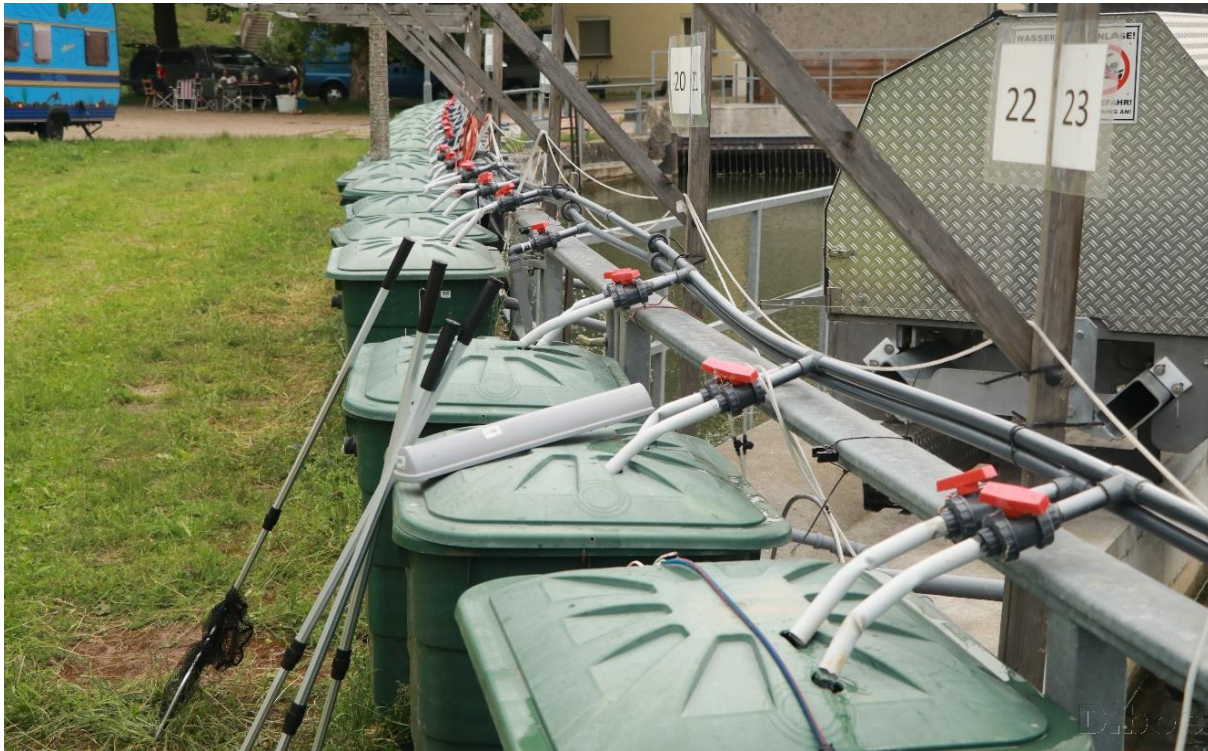
Abbildung 18: Nummerierte Kunststoffbecken der Hälterungsanlage mit Frischwasserzulauf und Frischluftversorgung
