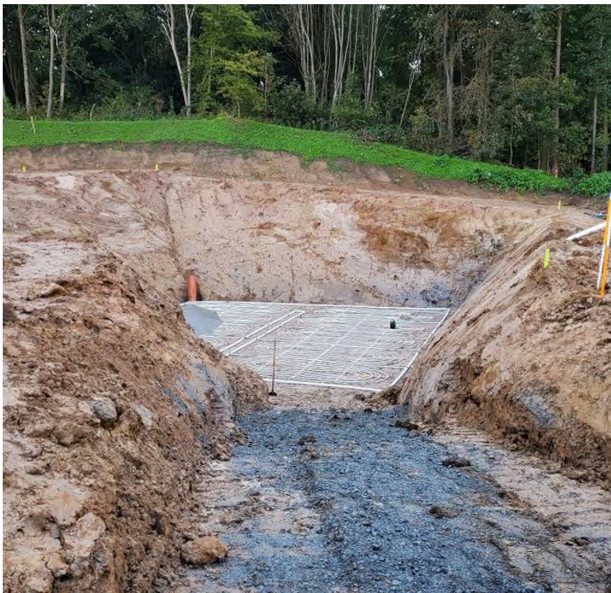
Abbildung 5: Unterste Ebene (ca. 160 m 2 ) des Erdeisspeichers 5 m unter Geländeoberkante
