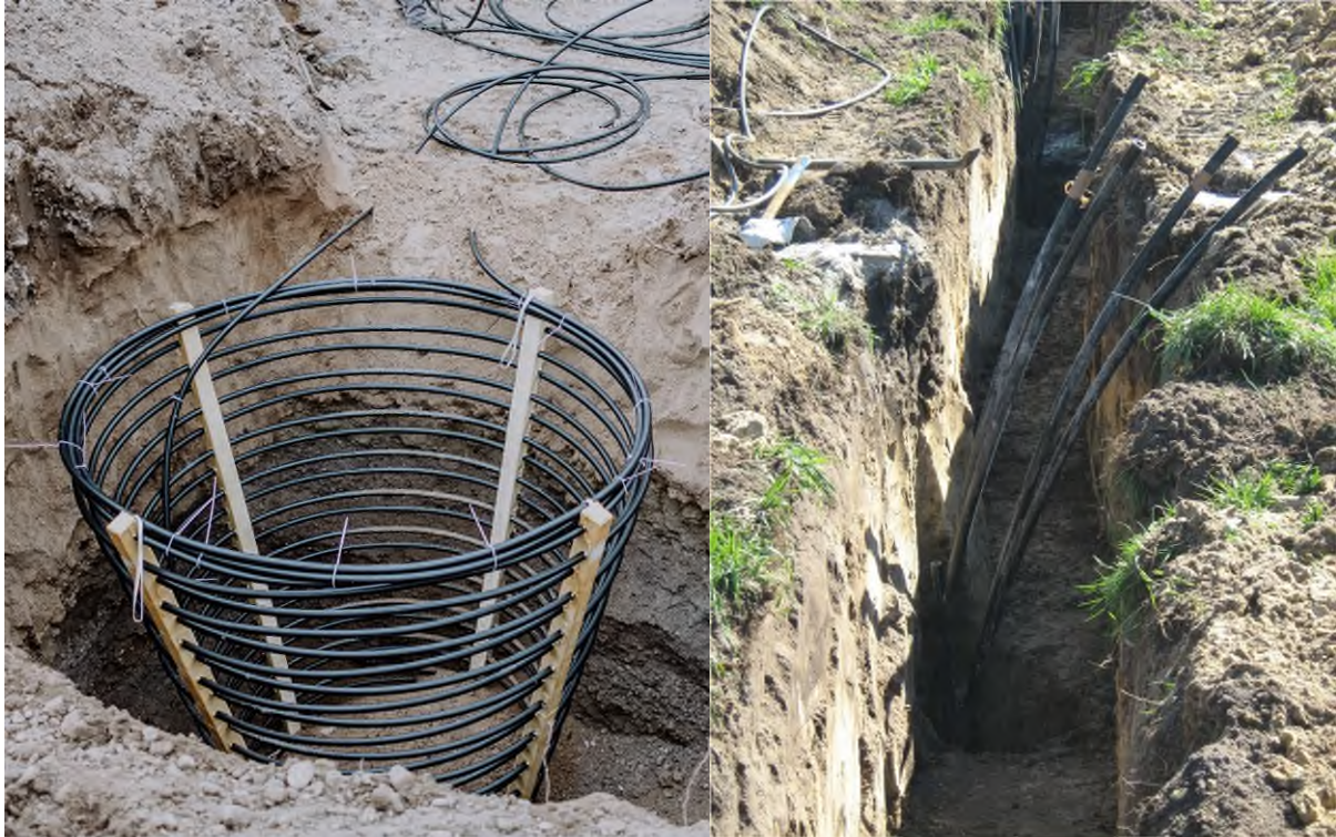
Abbildung 2: Beispiele eines Erdwärmekorbes (links) und eines Grabenkollektors (rechts)
