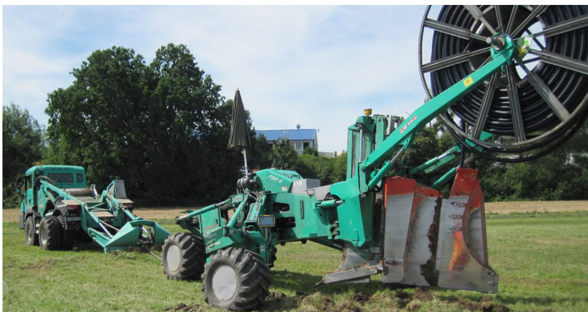
Abbildung 7: Einpflügen der Kollektorrohre durch ein Rohrflug auf der Agrothermie-Anlage in Radolfzell.
