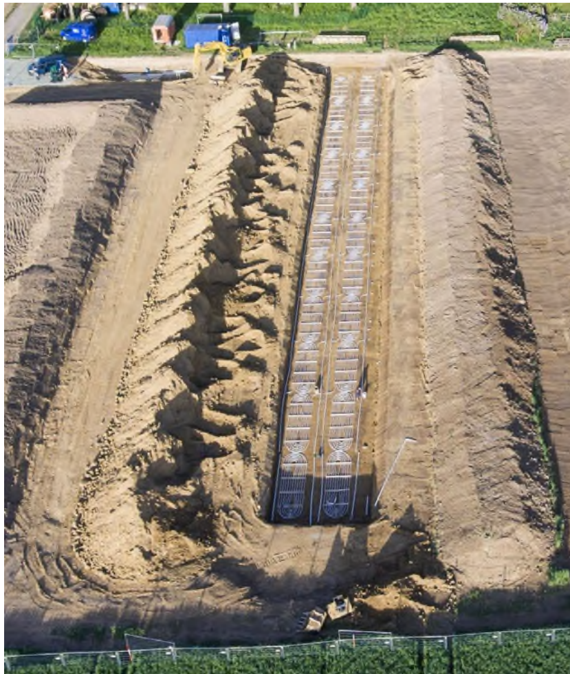
Abbildung 6: Einbau der Großkollektoranlage in Bad Nauheim.
