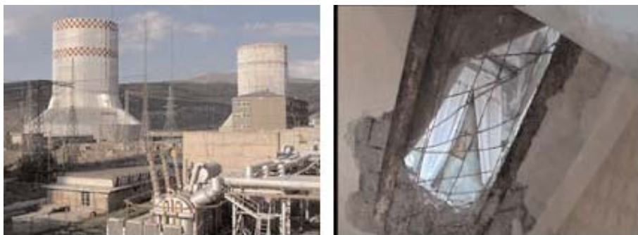
Рис. 2 Разрушение строительной площадки на Разданской ГЭС, ТЭЦ
